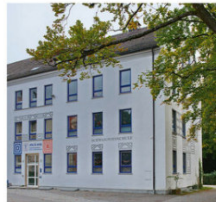
Die Schwaigwiesschule ist seit vielen Jahren Heimat der Volkshochschule Kempten. Das Gebäude ist nicht barrierefrei. Selbst der Zugang zu den Büroräumen im Erdgeschoss ist nicht barrierefrei möglich. ©Monika Rohlmann
