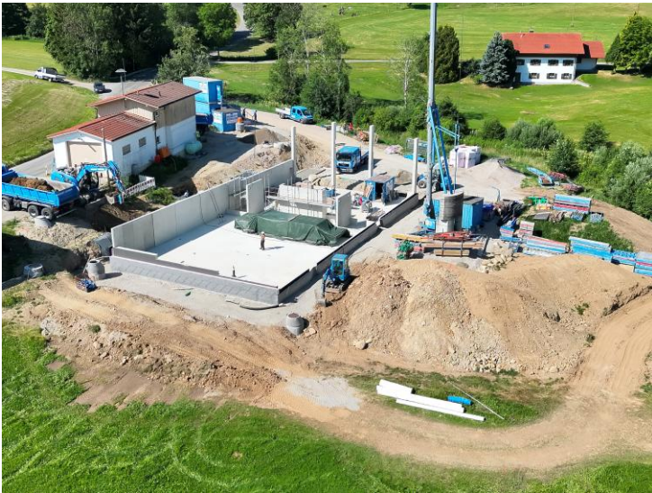
Neubau Feuerwehr Hohenrad
