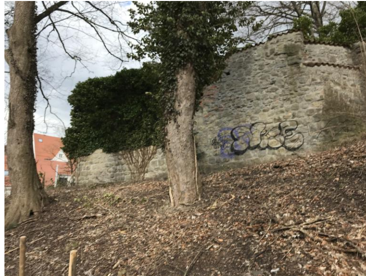
Entfernung von Bewuchs und Grafitti an der Mauer der Burghalde
