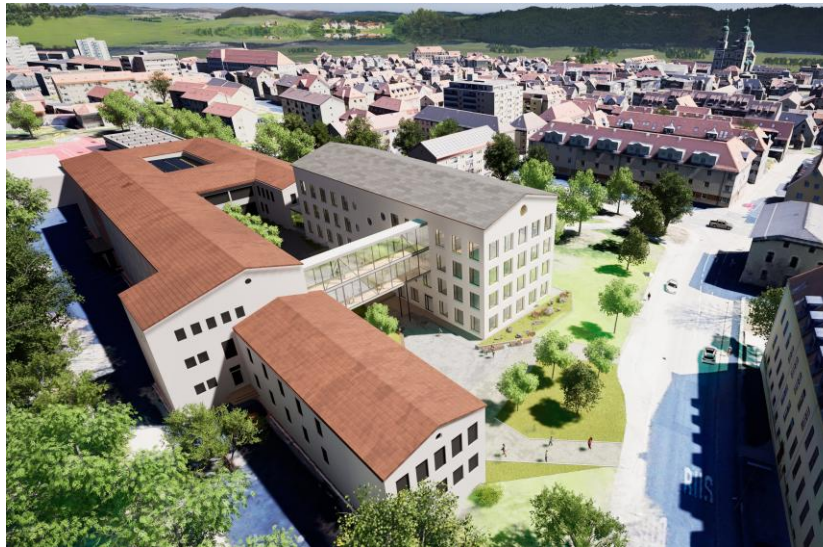
Carl-von-Linde-Gymnasium, Erweiterung und Sanierung
