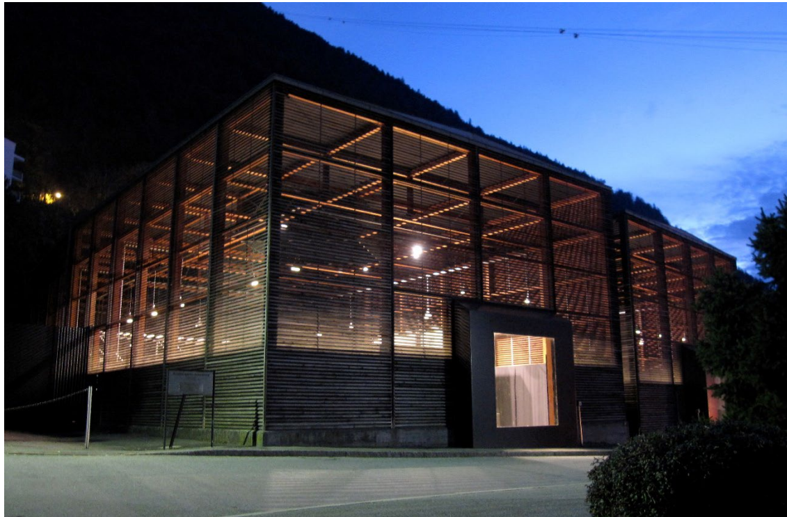
1. Peter Zumthor: Schutzbau für die Ausgrabung römischer Funde in Chur, Schweiz (Bildquelle: https://www.architekturbibliothek.ch/bauwerk/schutzbauten-fuer-ausgrabung-roemischer-funde/ )
