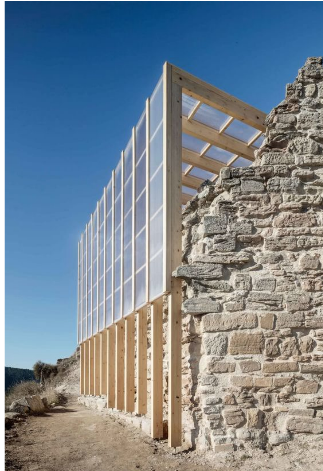
2. Holzkonstruktion auf Stahlbeton Fundament (Bildquelle: https://divisare.com/projects/438249-carles-enrich-adria-goula-landscape-adaptation-of-the-walled-enclosure-and-chapel-of-jorba-castle ).
