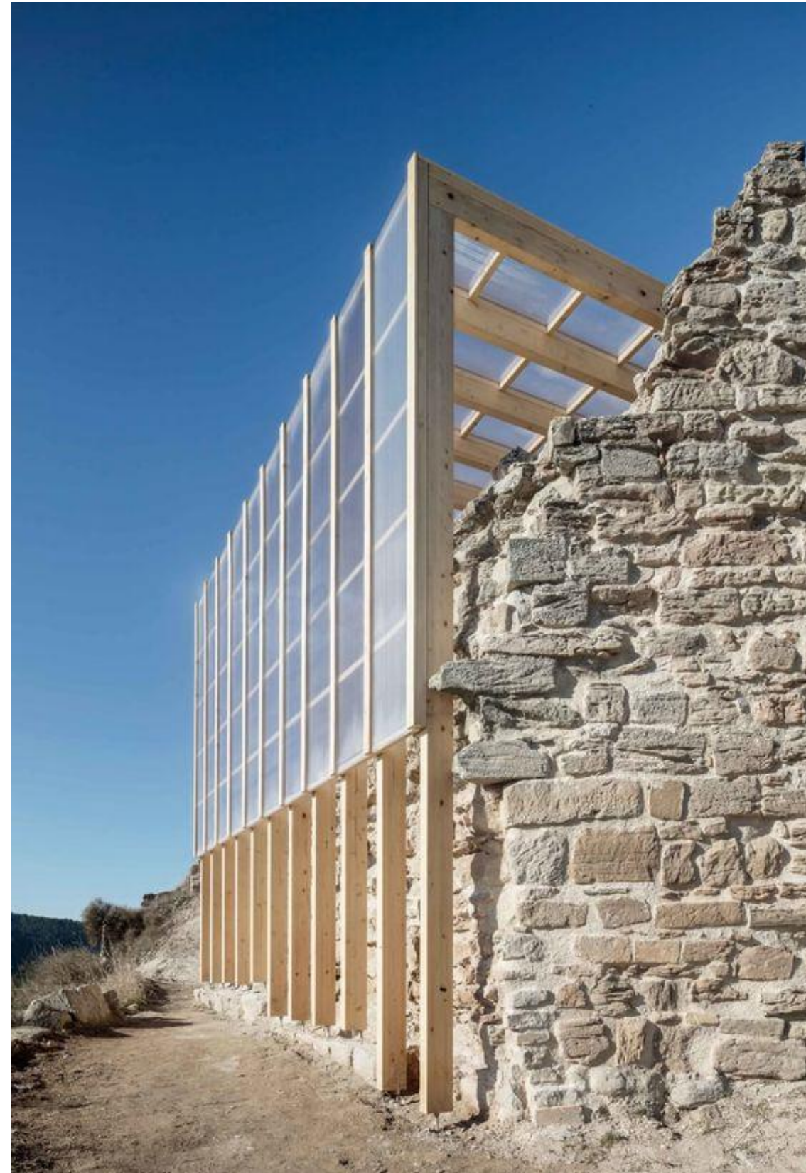
2. Holzkonstruktion auf Stahlbeton Fundament (Bildquelle: https://divisare.com/projects/438249-carles-enrich-adria-goula-landscape-adaptation-of-the-walled-enclosure-and-chapel-of-jorba-castle ).
