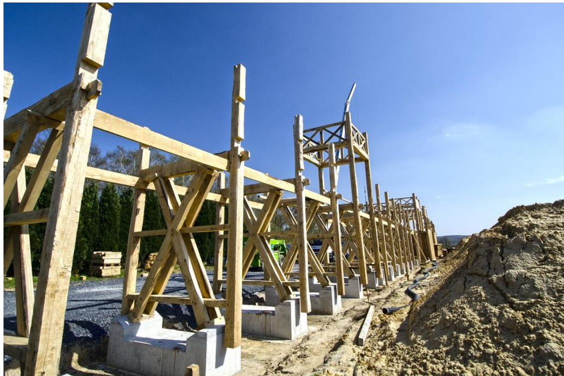
2. Baustelle zur Reskonstruktion: Betonierte Fußpunkte mit zimmermannsmäßig gefertigten Holzbauteilen (Lärchenholz).
