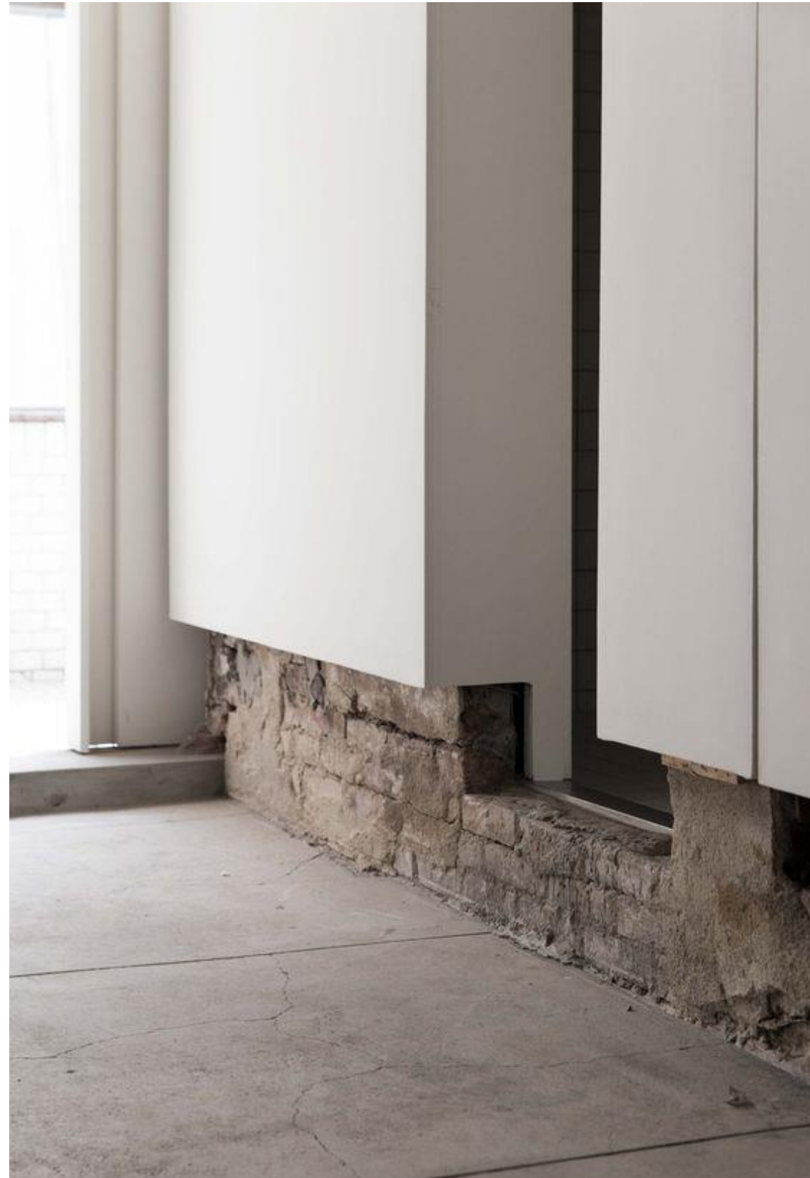
2. Neutrale Wandgestaltung über historischem Fundament (Bildquelle: https://divisare.com/projects/143424-joao-luis-carrilho-da-graca-global-arquitectura-paisagista-duarte-belo-fernando-guerra-fg-sg-praca-nova-do-castelo-de-sao-jorge )
