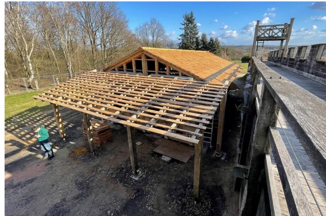
3. Der Bau erfolgte in mehreren Bauabschnitten.
