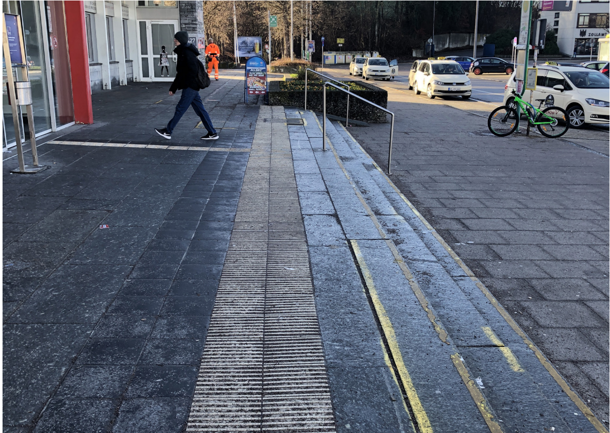
Stufen zum Bahnhofgebäude
