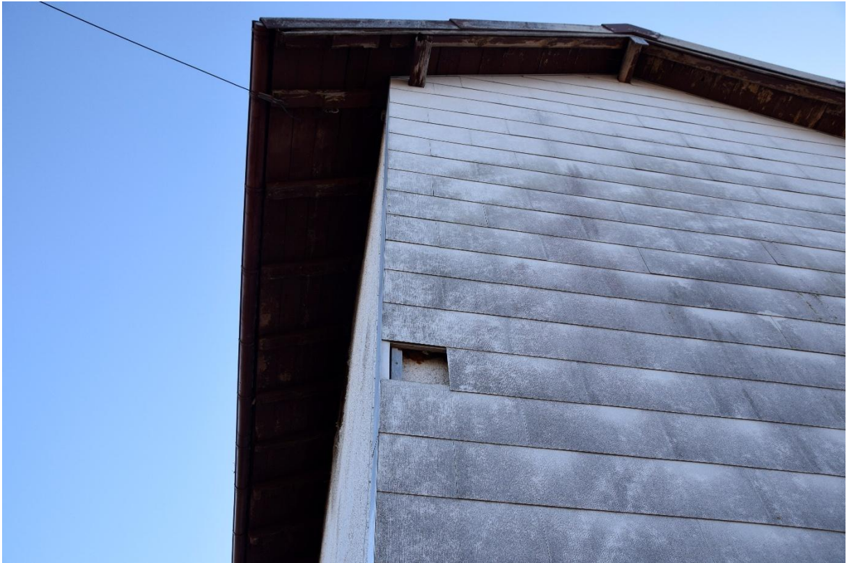
Abbildung 6: Hohlraum in der Westfassade durch fehlendes Verkleidungselement
