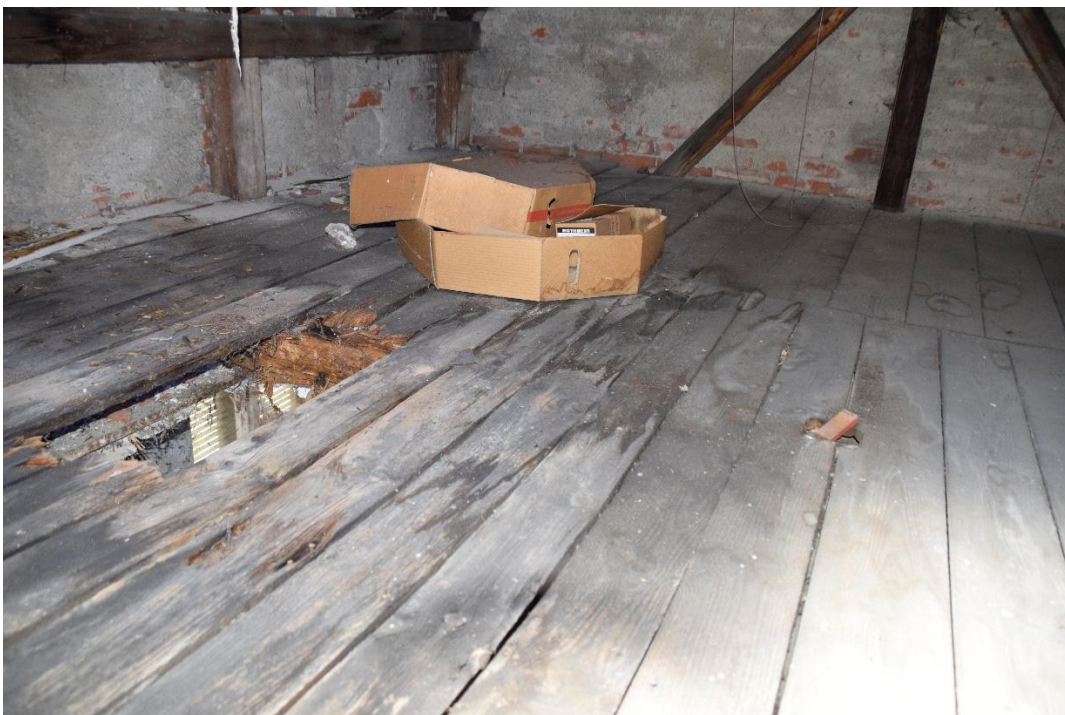
Abbildung 7: Westlicher Dachstuhlbereich mit durchgebrochenen Brettern
