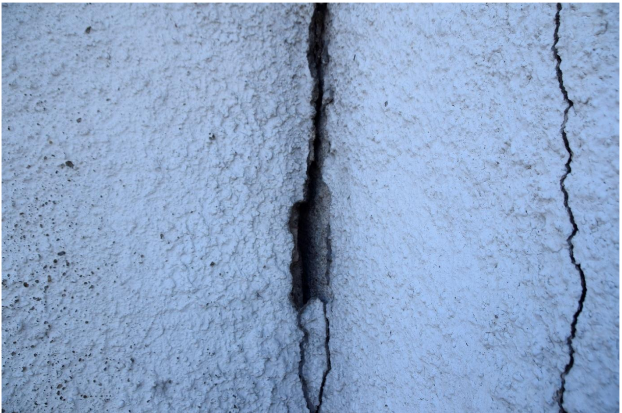
Abbildung 7: Spalt im Mauerwerk an der Nordseite des Gebäudes
