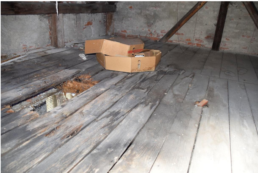
Abbildung 7: Westlicher Dachstuhlbereich mit durchgebrochenen Brettern
