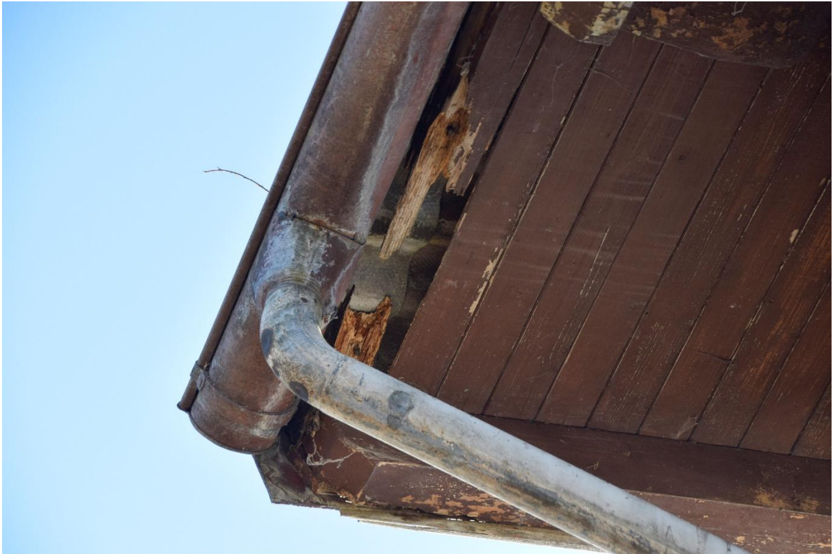
Abbildung 4: Öffnung im Dachbereich an der Nordostseite des Gebäudes
