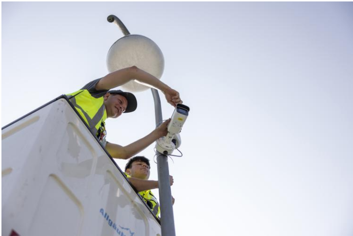
Foto: Philip Herzhoff, Installation der Verkehrskamera an der St.-Mang-Brücke
