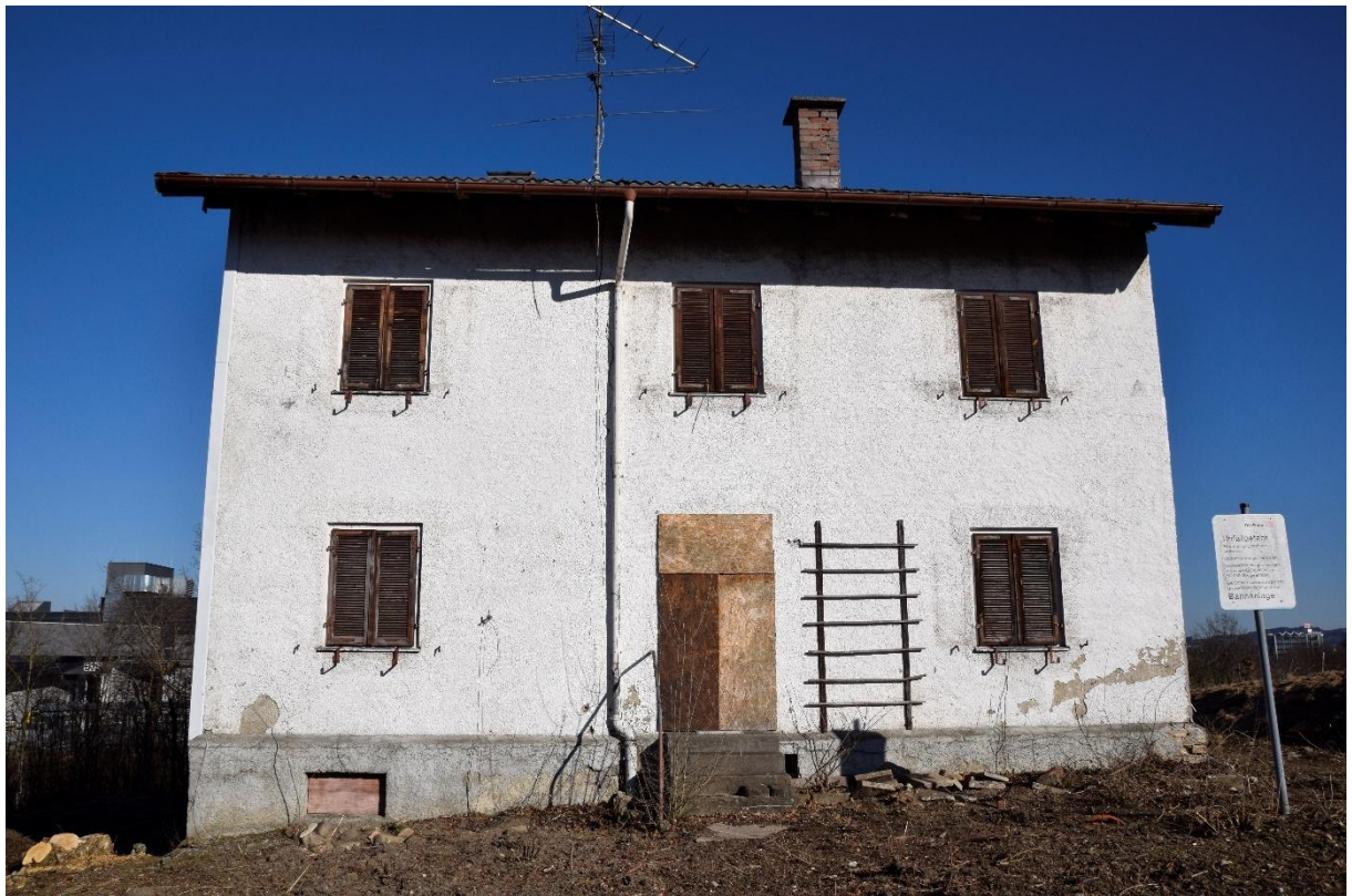
Abbildung 3: Südansicht des abzureißenden Gebäudes
