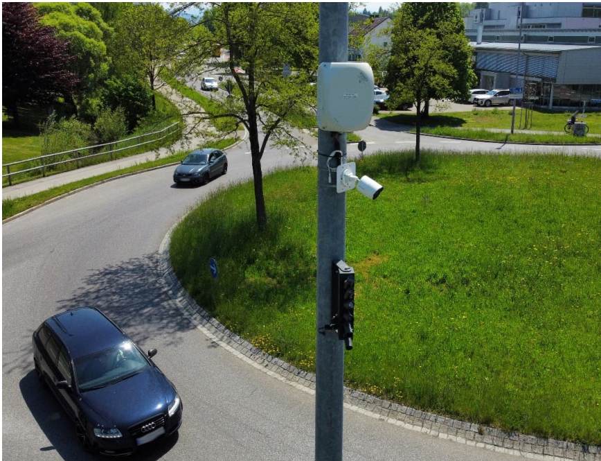
Foto: Smart City, Verkehrszählung in der Memmingerstraße, Dachserkreisel
