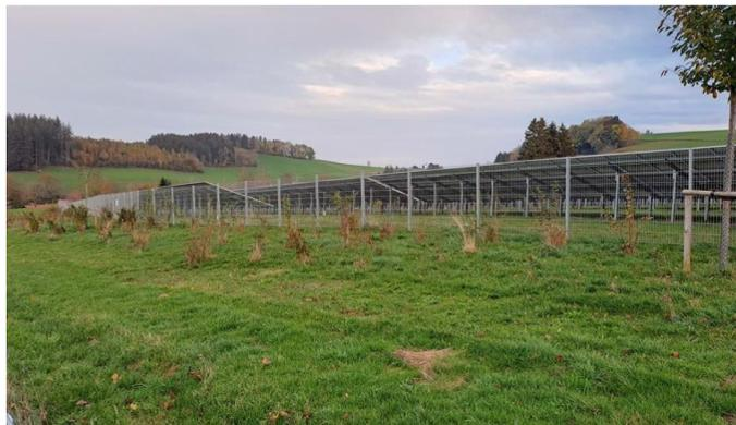
Photovoltaikanlage, 2-reihig (nur 2,80 Meter nicht 4 Meter hoch) mit Gitterzaun und Bepflanzung!!!!
