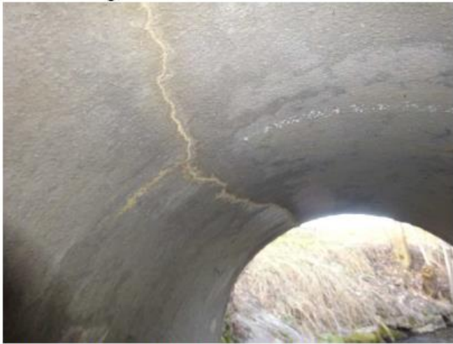
HP2022_RISSE MIT AUSSINTERUNGEN
