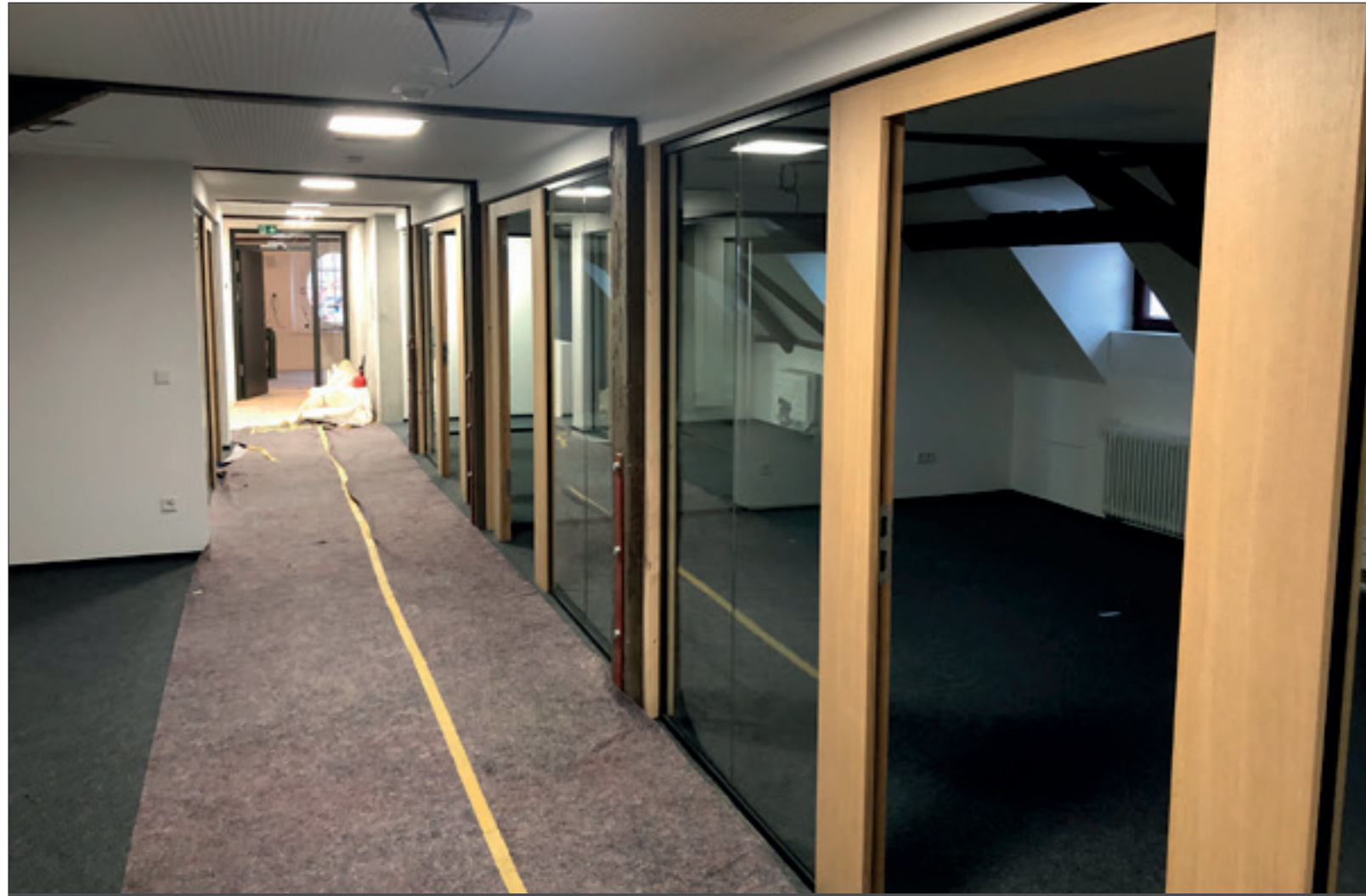
1. Ausbaustand Büroräume DG2
