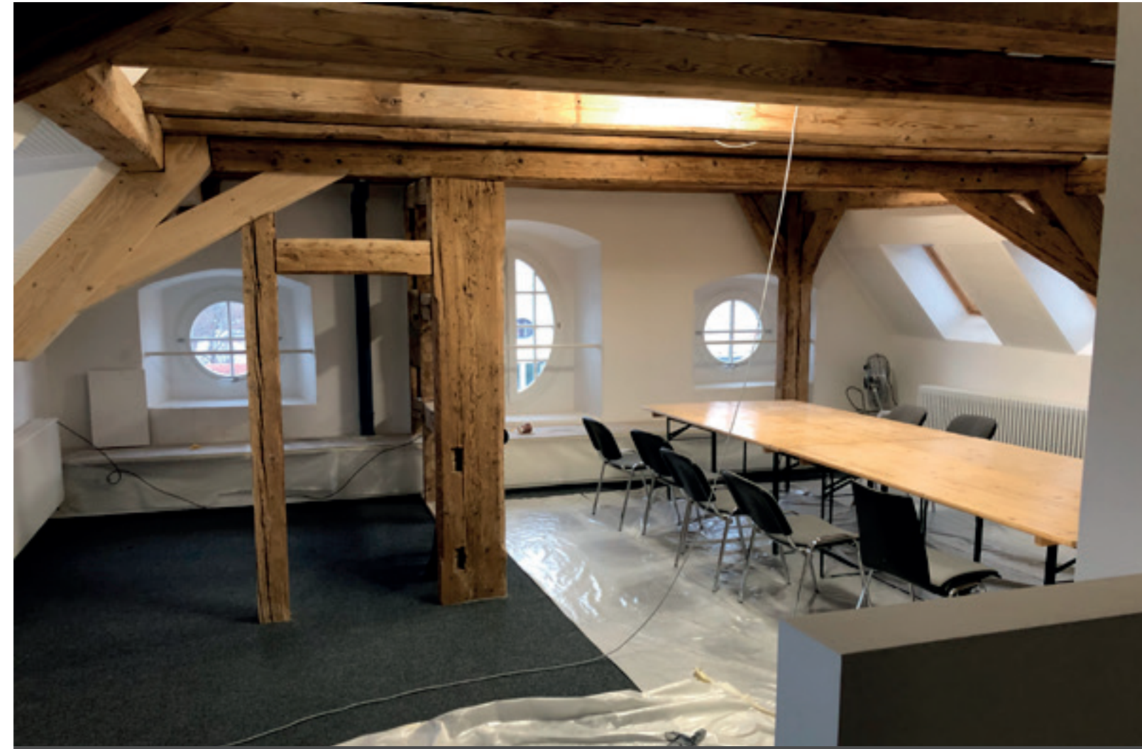
2. Ausbaustand Besprecher Ostflügel
