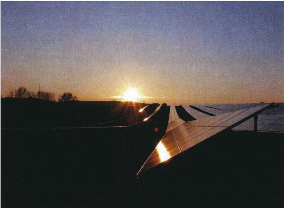
Abb. 3: Blendungssituation bei streifendem Lichteinfall gem. [4]
