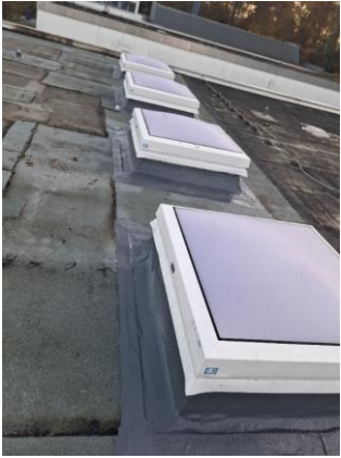
Allgäu-Gymnasium: Ausbesserung Flachdach Sporthalle nach Wasserschaden im Frühjahr 2024
