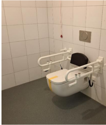
Sing- und Musikschule: Schaffung eines behindertengerechten WC
