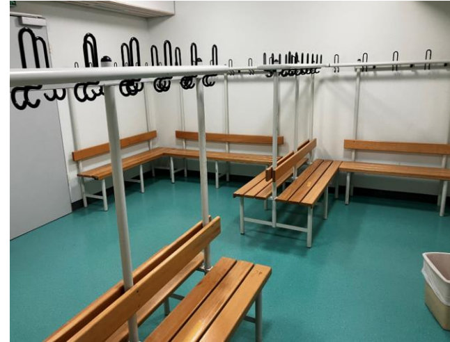
Illerstadion: Sanierung Umkleide und brandschutztechnische Erüchtigung des Tribünnengebäudes
