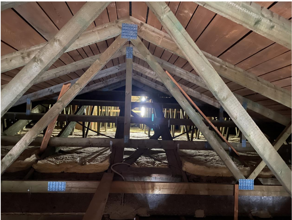
Abbildung 4: Blick in den Dachstuhl des EDEKA-Gebäudes
