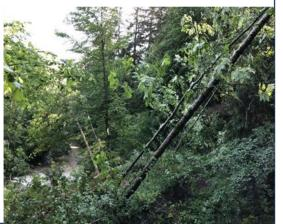
Nach den Regenereignissen im Juni ist hinter dem Klinikgelände ein Hang an der Rottach auf einer Fläche von ca. 400m² abgerutscht. Gerade laufen Bodenuntersuchungen als Grundlage für die Lösungsfindung.
