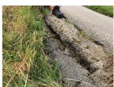
Sicherung der abgerutschten Böschung östlich der Tannachstraße mittels Spundwänden. Anschließend Wiederaufbau des Bankettbereichs
