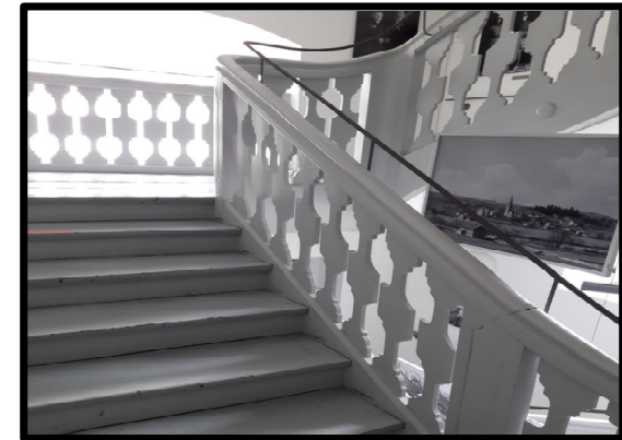
Denkmalgeschützte Treppe Nord
