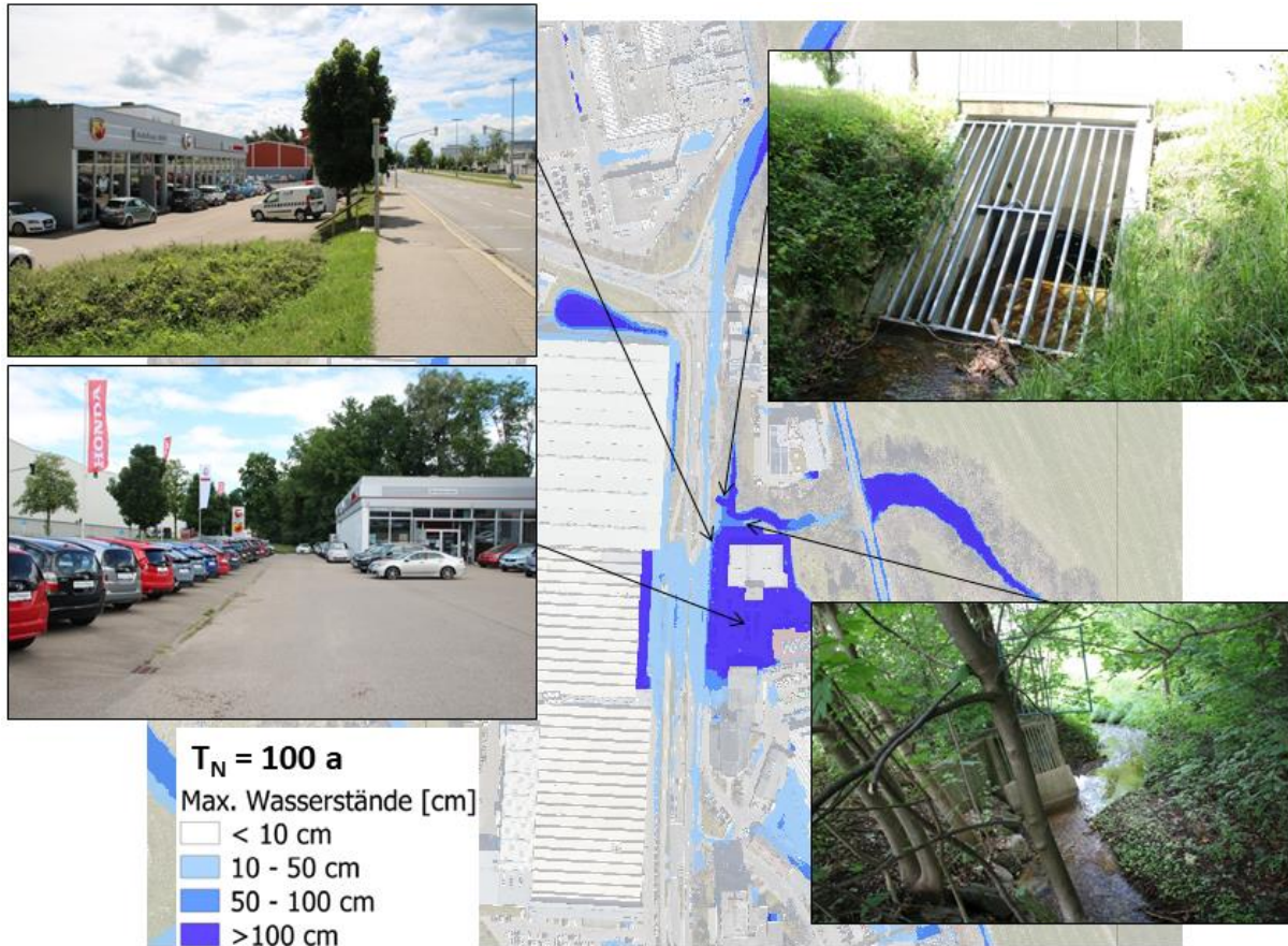
Abbildung 20: Überflutungsschwerpunkt Kaufbreuer Straße/Holzbach
