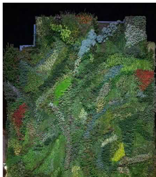
Abbildung 58: Fassadengebundene Begrünung als Teil der Fassade des „La Caixa Forum“ in Madrid (2016).
