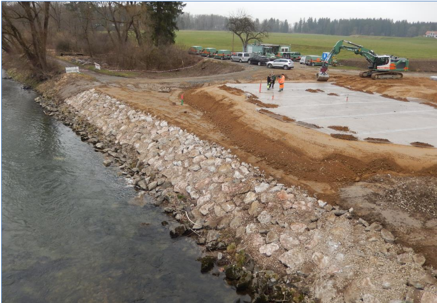
Einbau von Geogitter-Lagen zur Erhöhung der Dammfestigkeiten. Stand: Februar 2024
