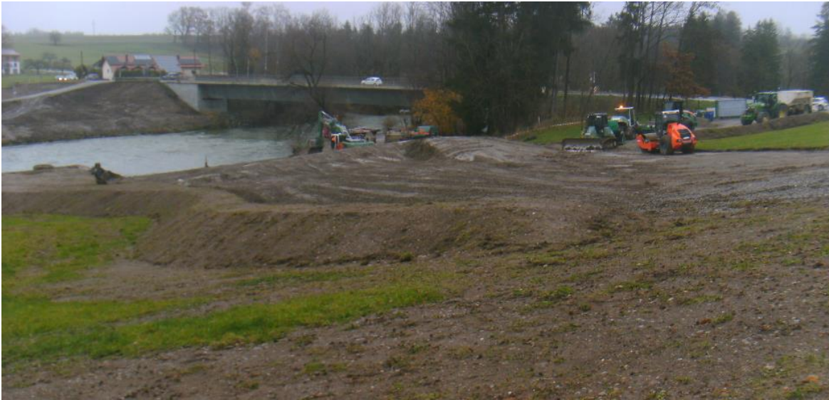
Herstellung der Dammvorschüttungen, Stand: November 2023
