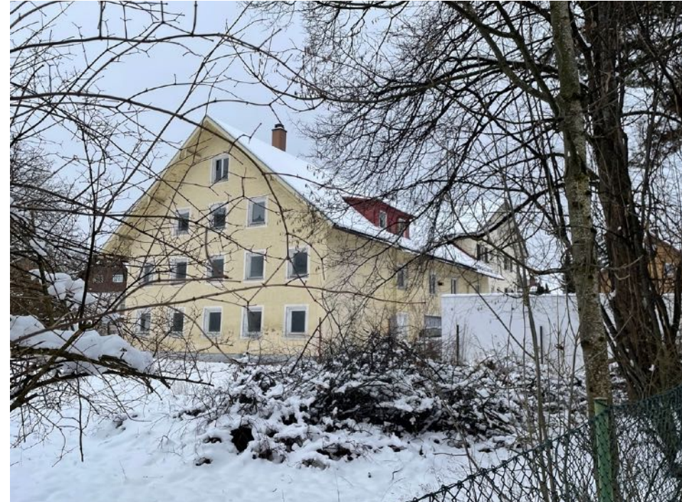
Bestandsgebäude (geplanter Abbruch)
