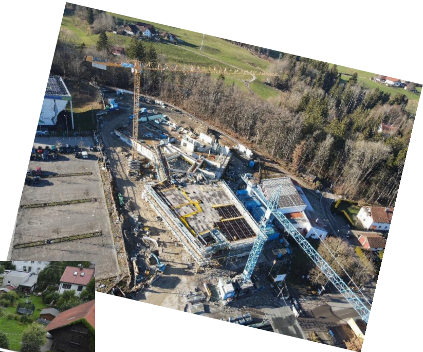
Grundschule am Aybühlweg
