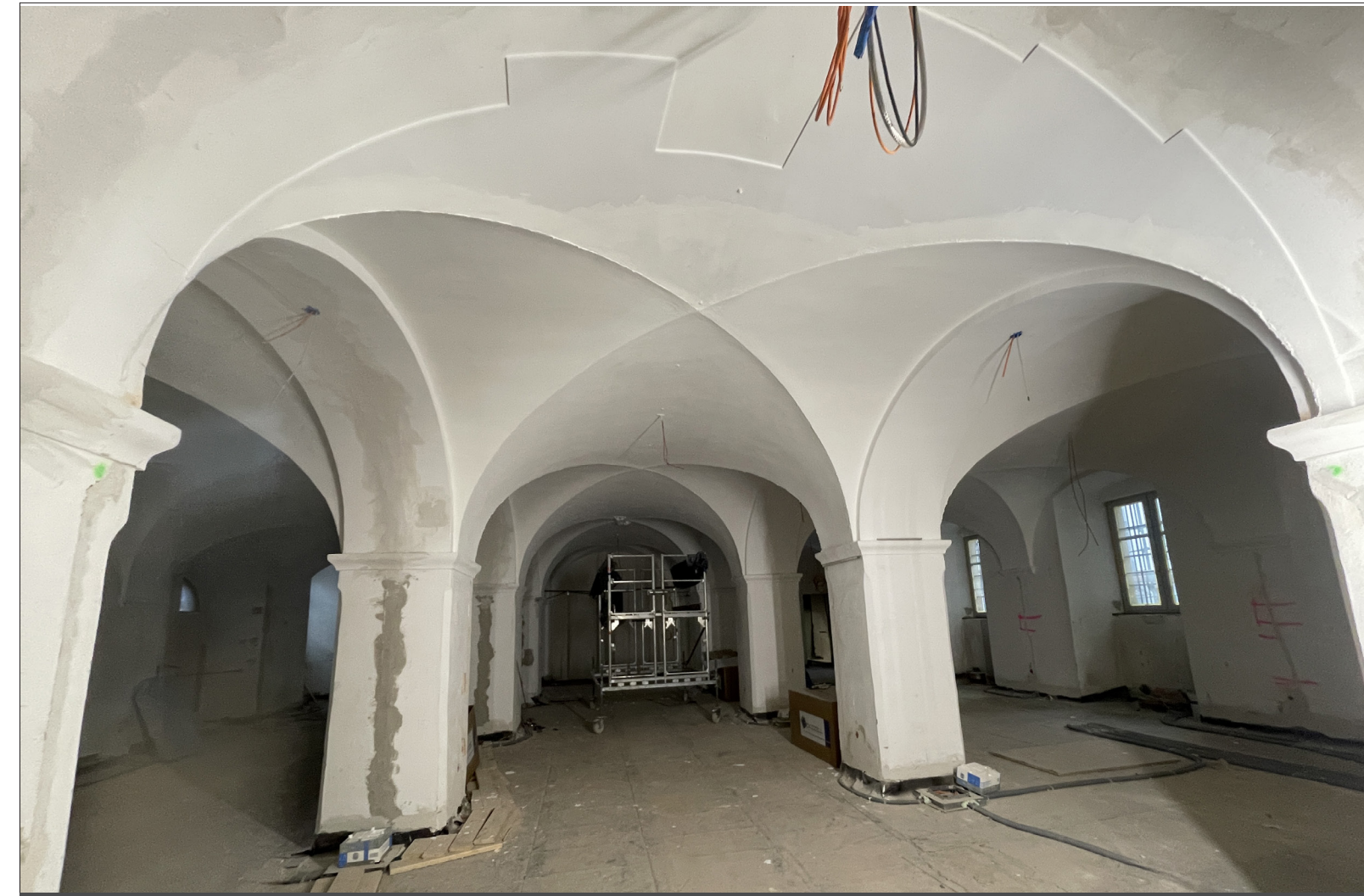
1. Akustikputzarbeiten Gewölbe EG
