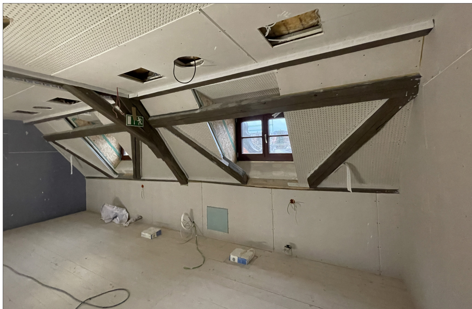
2. Ausbaustand Büroräume DG2
