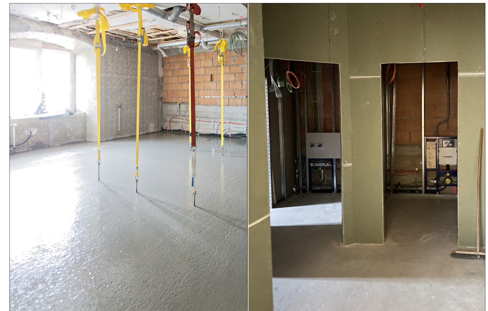
4. Ertüchtigung WC-Anlagen und Scheingewölbe
