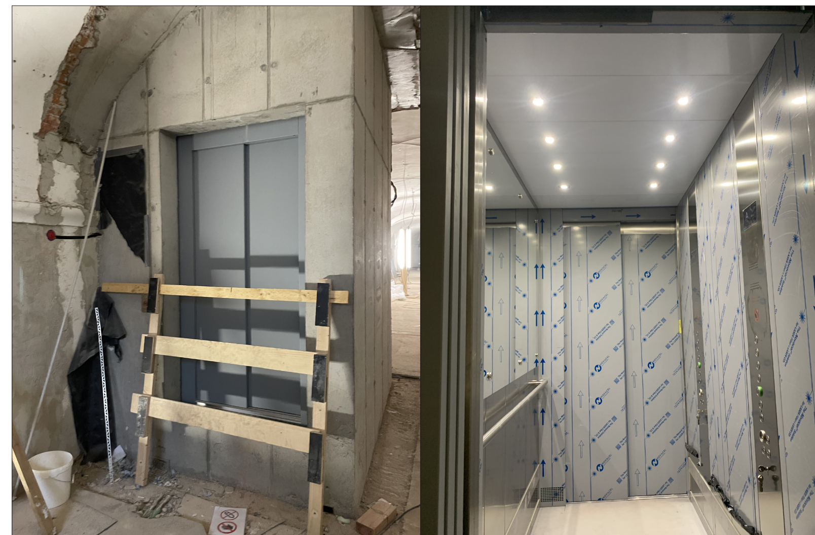
3. Einbau neuer Aufzug
