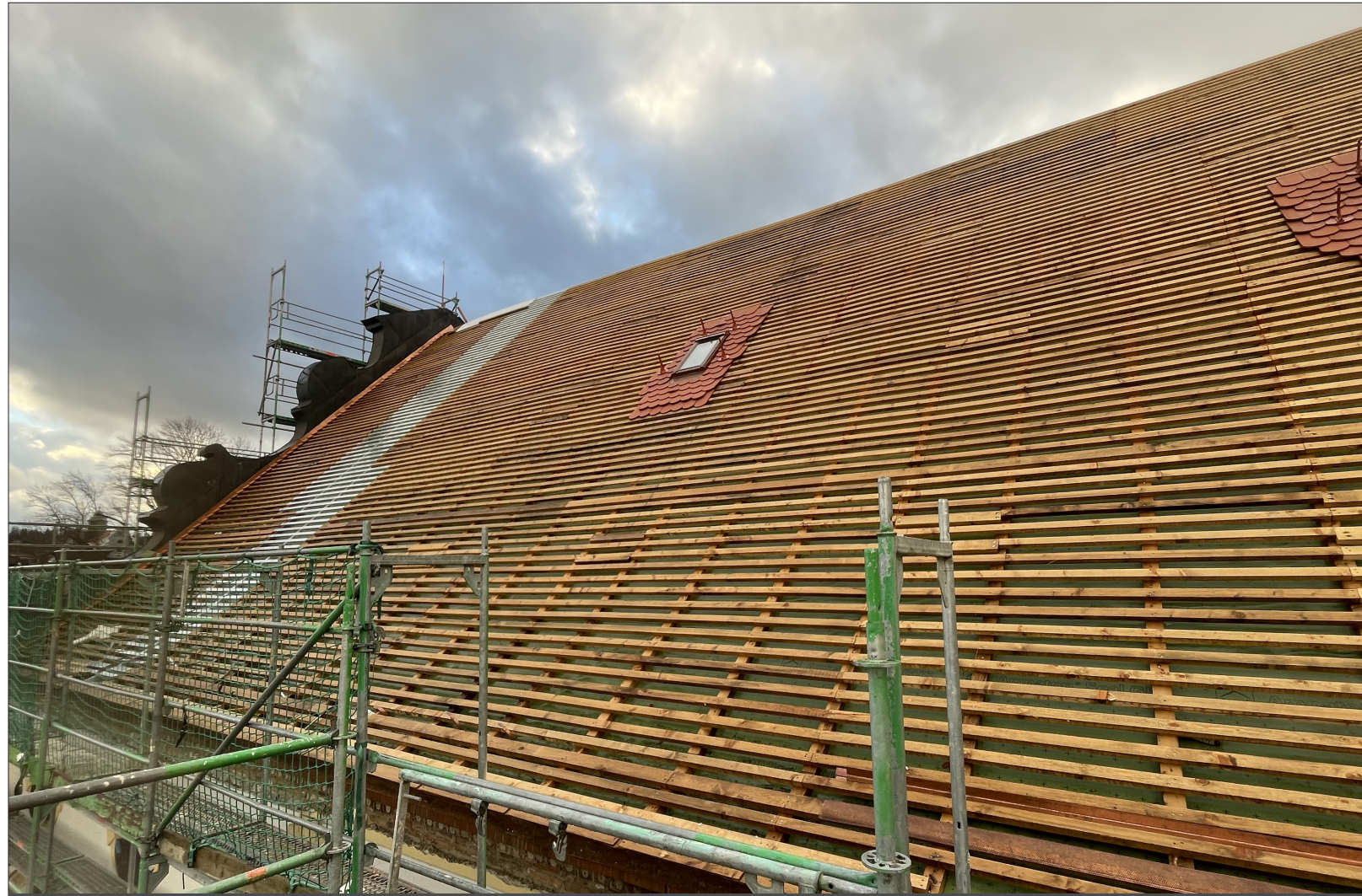
1. Dach_Lattung + Schalung fertig
