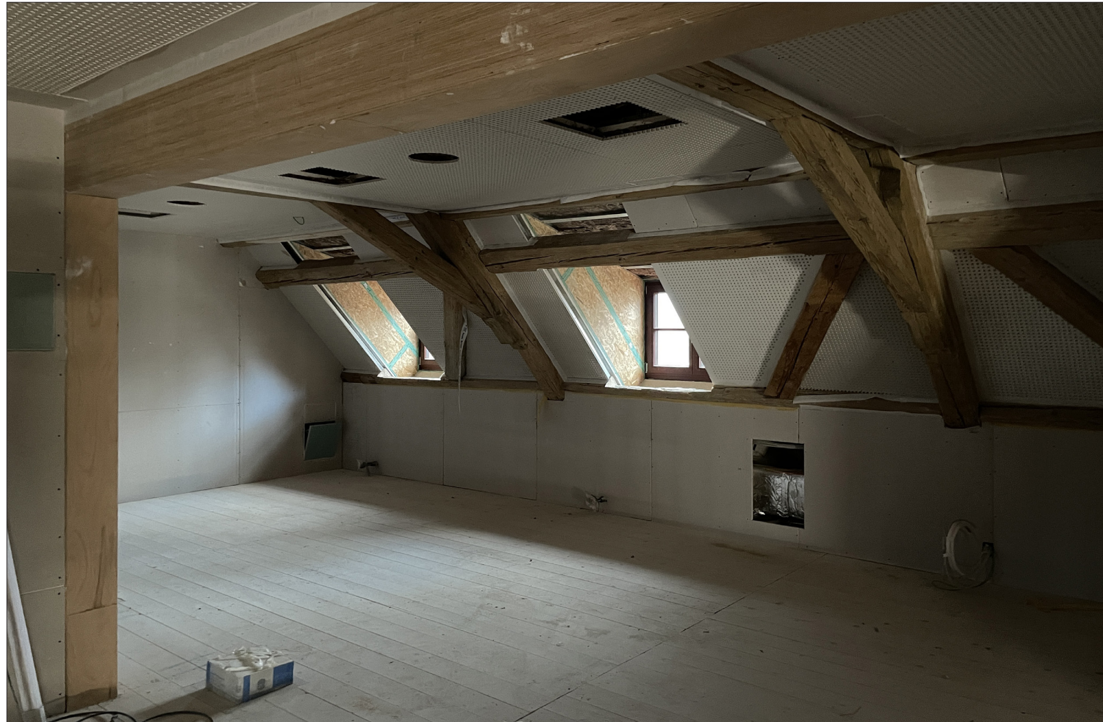
1. Ausbaustand Büroräume DG1
