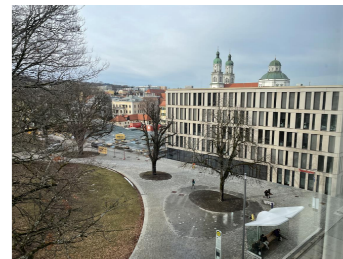
Neue Hauptstelle Sparkasse Allgäu, © DAL REM
