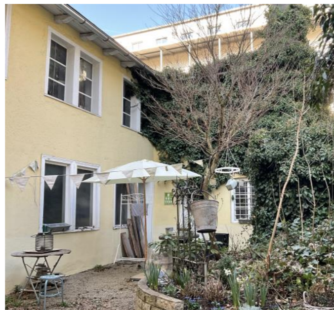
Innenhof Promenadestr. 5, © DAL
