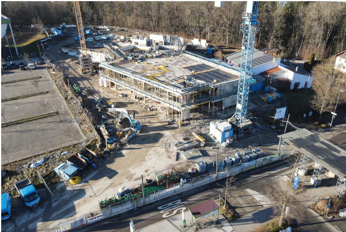
Blick von Osten auf Baustelle und Aybühlweg
