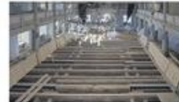
■ Sogar die Zwischenräume mussten entkernt werden. Sie waren mit Bauschutt verfüllt worden.
