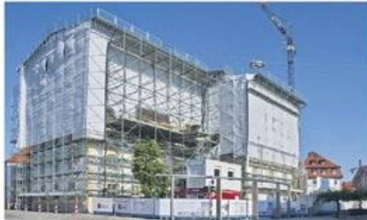
■ Das Kornhaus wird derzeit saniert. Für die Arbeiten wurde sogar eigens ein »Wetterdach« über das markante Gebäude gestülpt.
