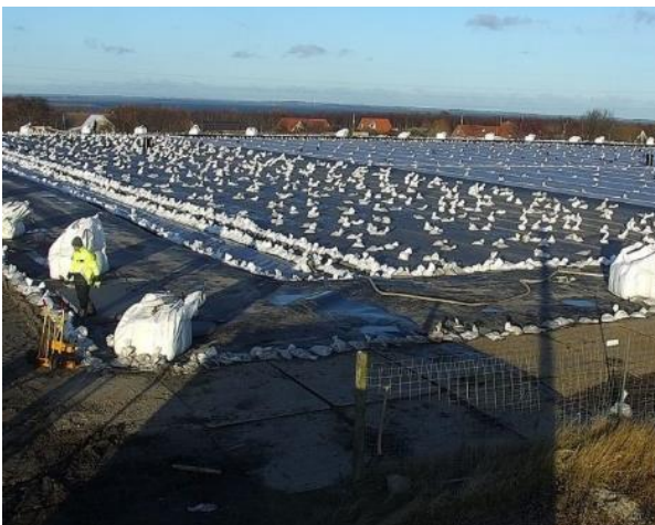
Erdbeckenspeicher, Arcon-Sunmark
