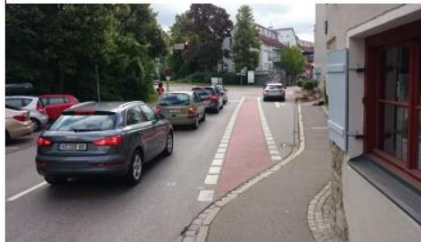
Fehlender Schutzstreifen oder Radfahrstreifen im Bereich der Illerstraße bis zur Hausnummer 14
