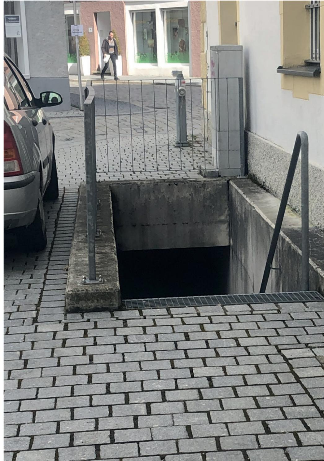
2. Blick von Anlieferung: Betonaufkantung als UK der Überdachung
