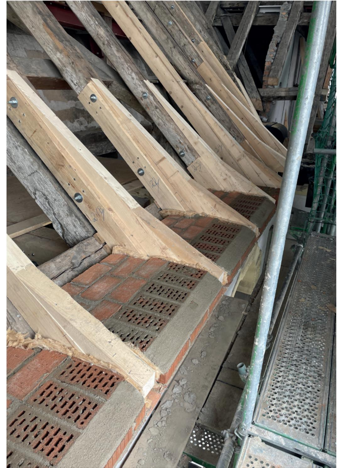
3. Traufgesims mit Aufschieblingen im sanierten Zustand
