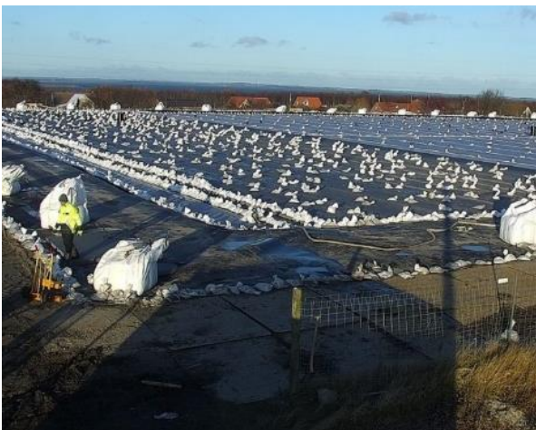
Erdbeckenspeicher, Arcon-Sunmark
