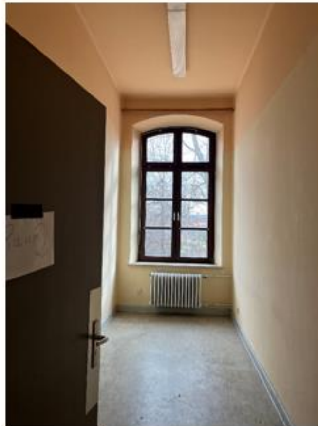
Schmaler Raum im EG – beidseitig tragende Wände
