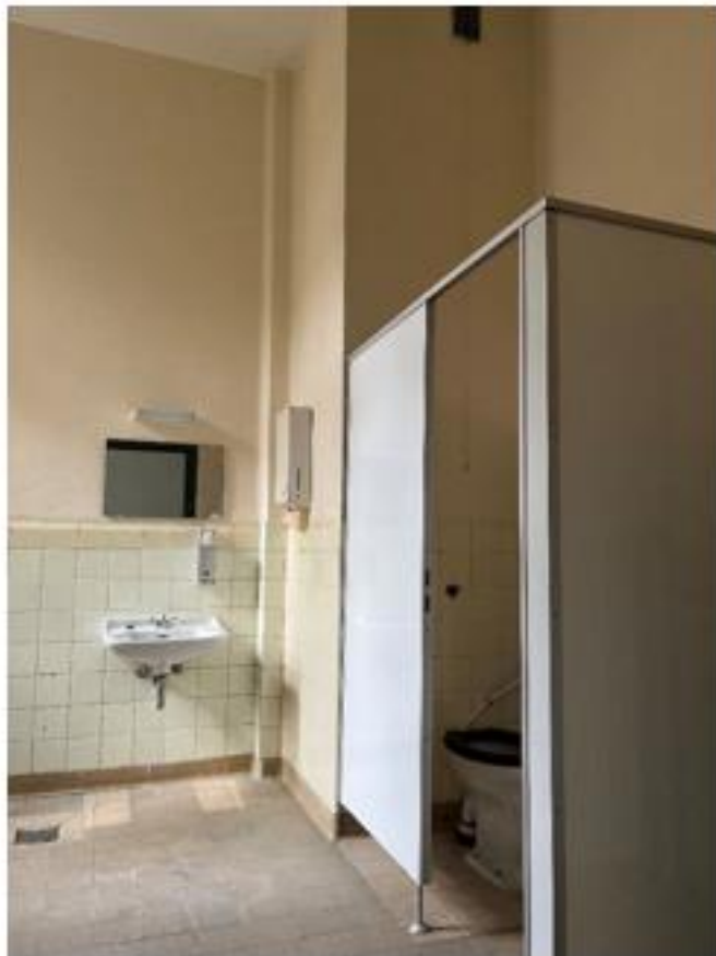
Sanitärräume EG klein und hoch
