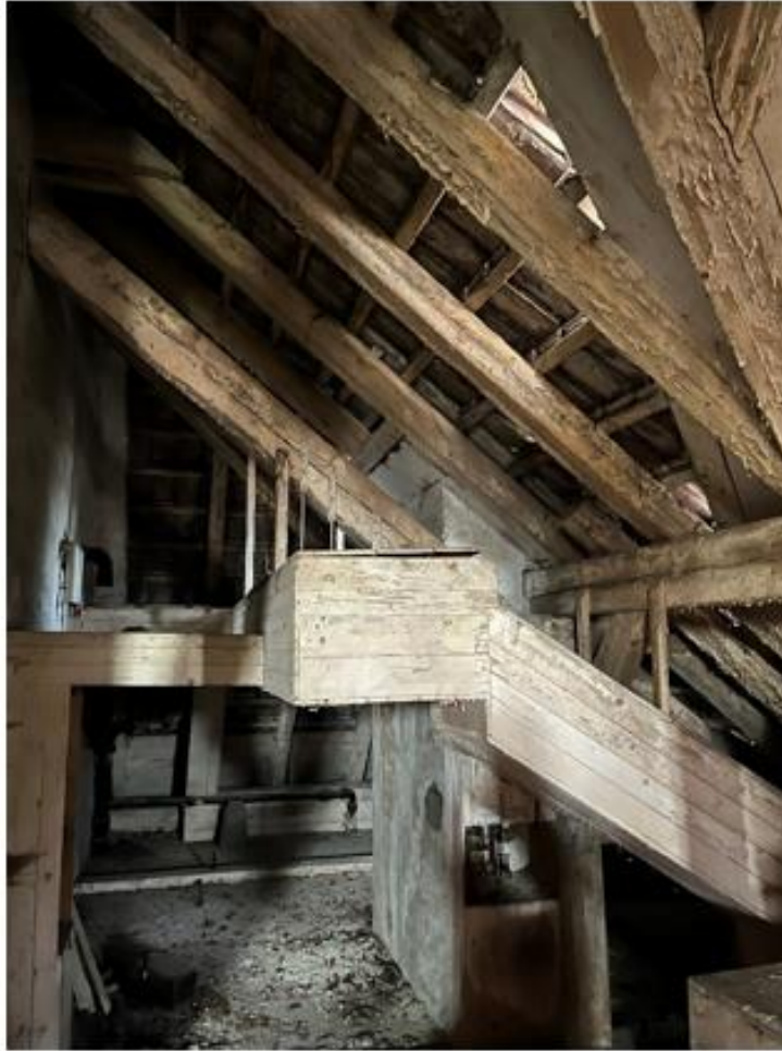
Dachstuhl mit Installation
