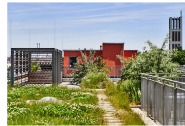
Extensive Dachbegrünung, Terrassen und Pergola
