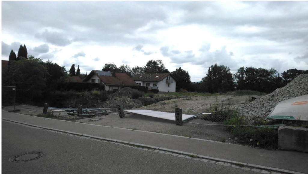
Bild 1: Einfahrt Straße „Neuhausen“
