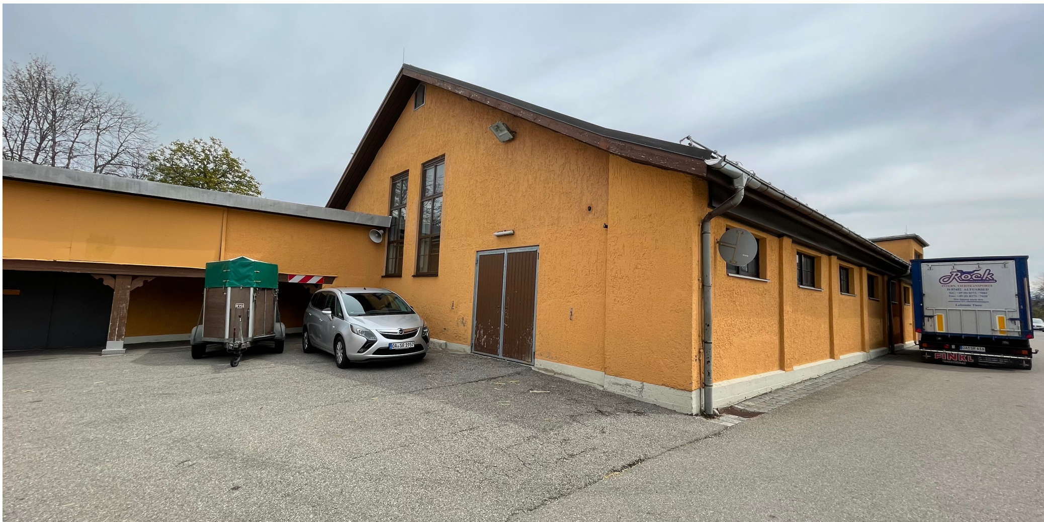
Ansicht Nord Halle 2 (Tierzuchthalle)
