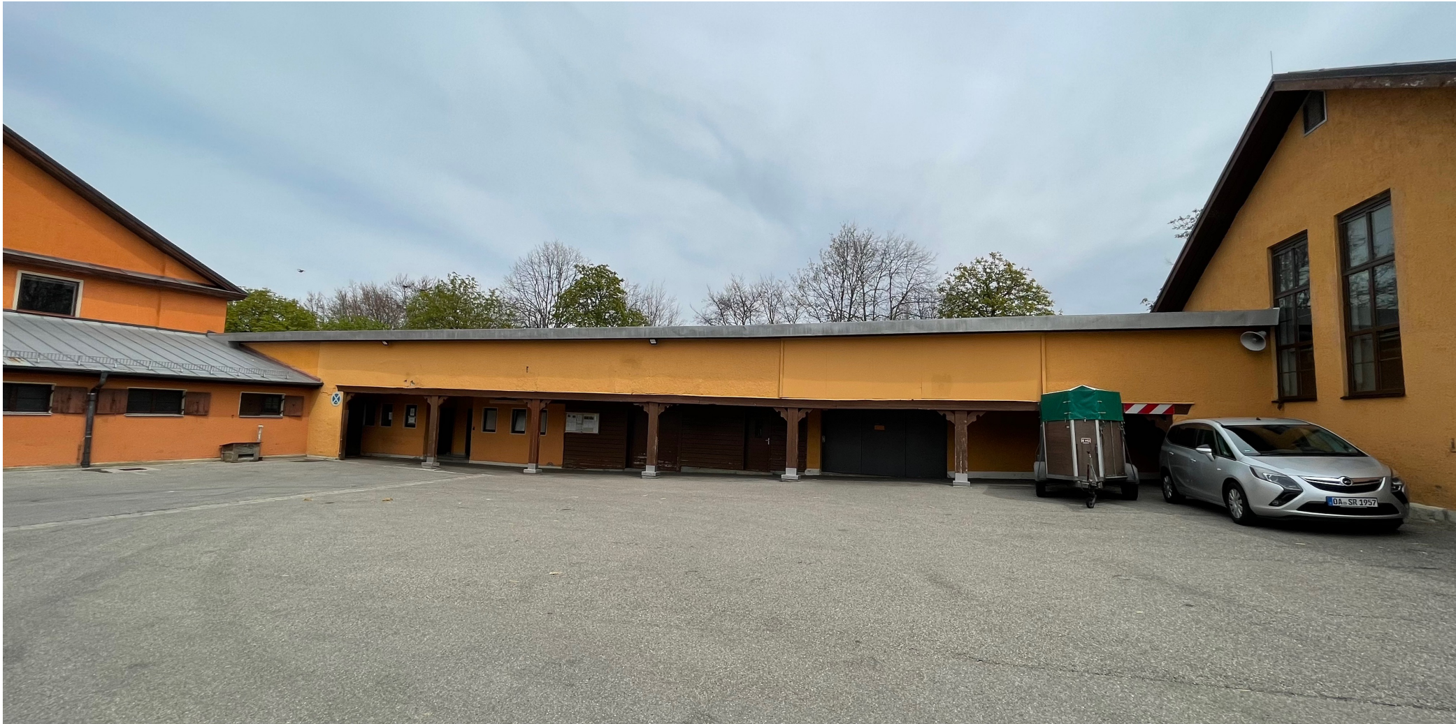
Ansicht West Zwischenbau
