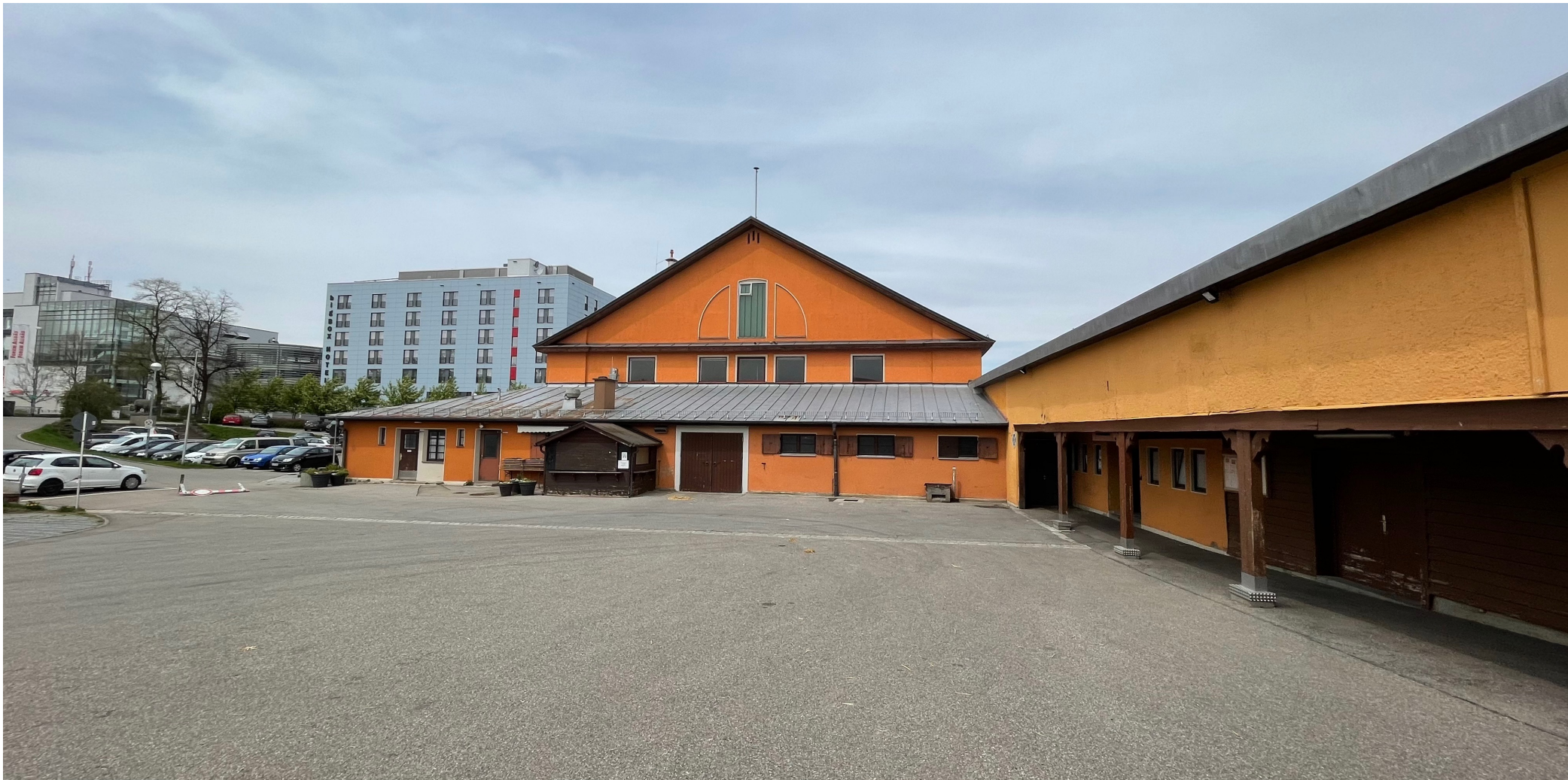
Ansicht Süd mit Zwischenbau
