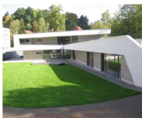
Kindertagesstätte Oberlinhaus erstes stadteigenes Plus-Energie-Gebäude Wärmeversorgung mit Wärmepumpe
