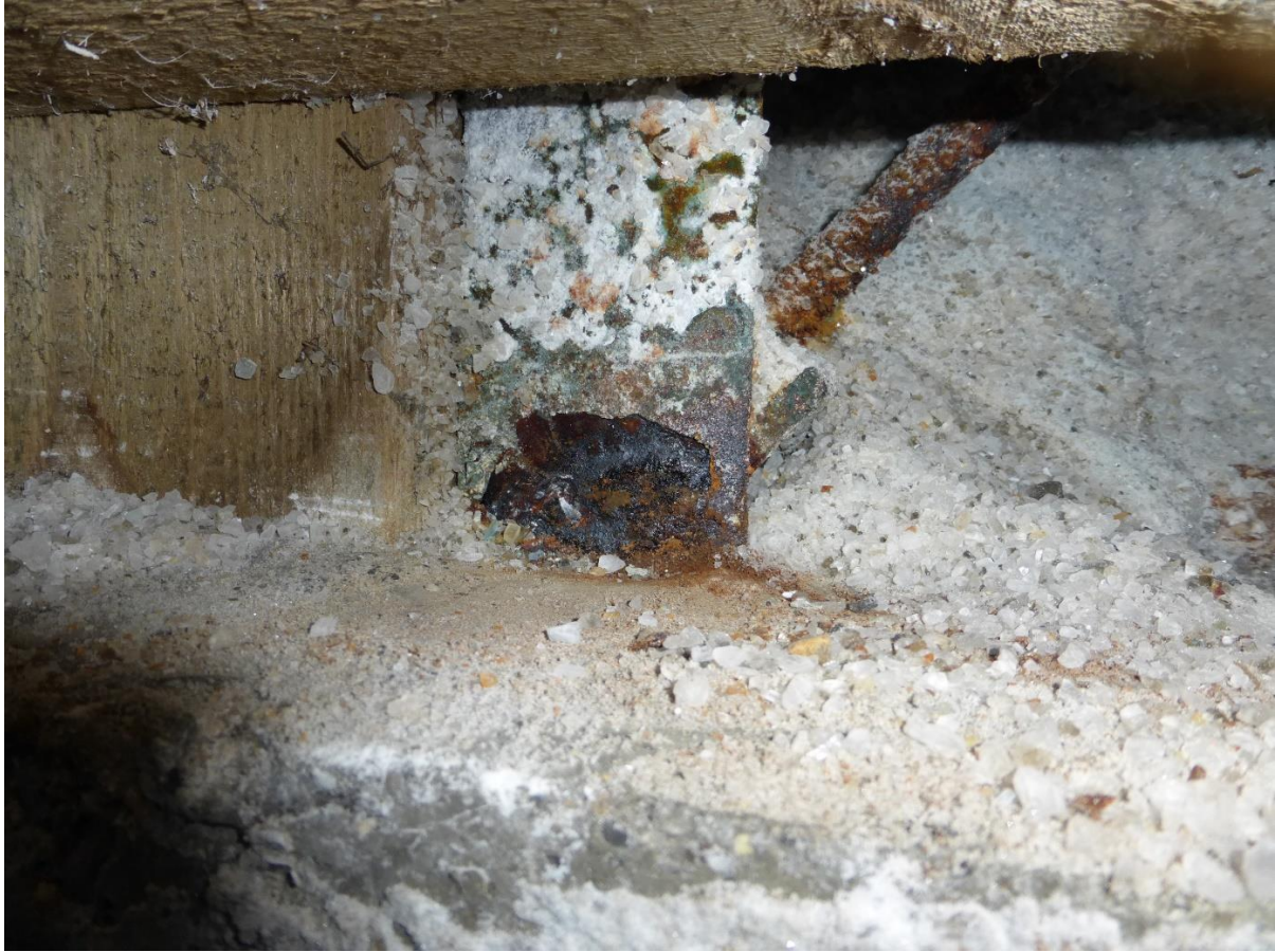
Zunehmende Schädigung an Stützeinspannungen durch Salzeintrag
