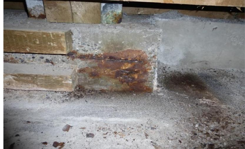
Starker Chlorideintrag bei den Stahlbetonfundamenten
