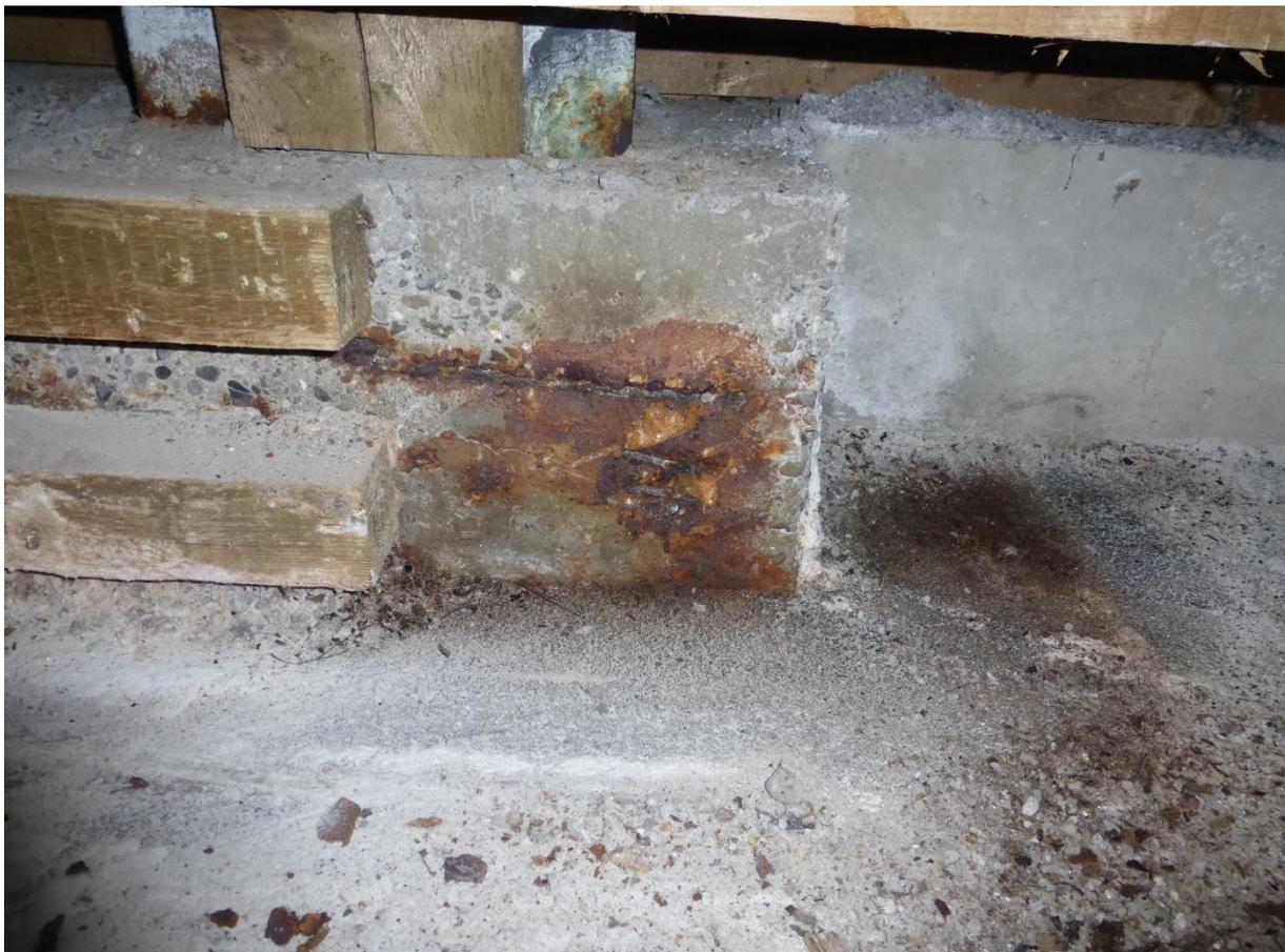
Starker Chlorideintrag bei den Stahlbetonfundamenten
