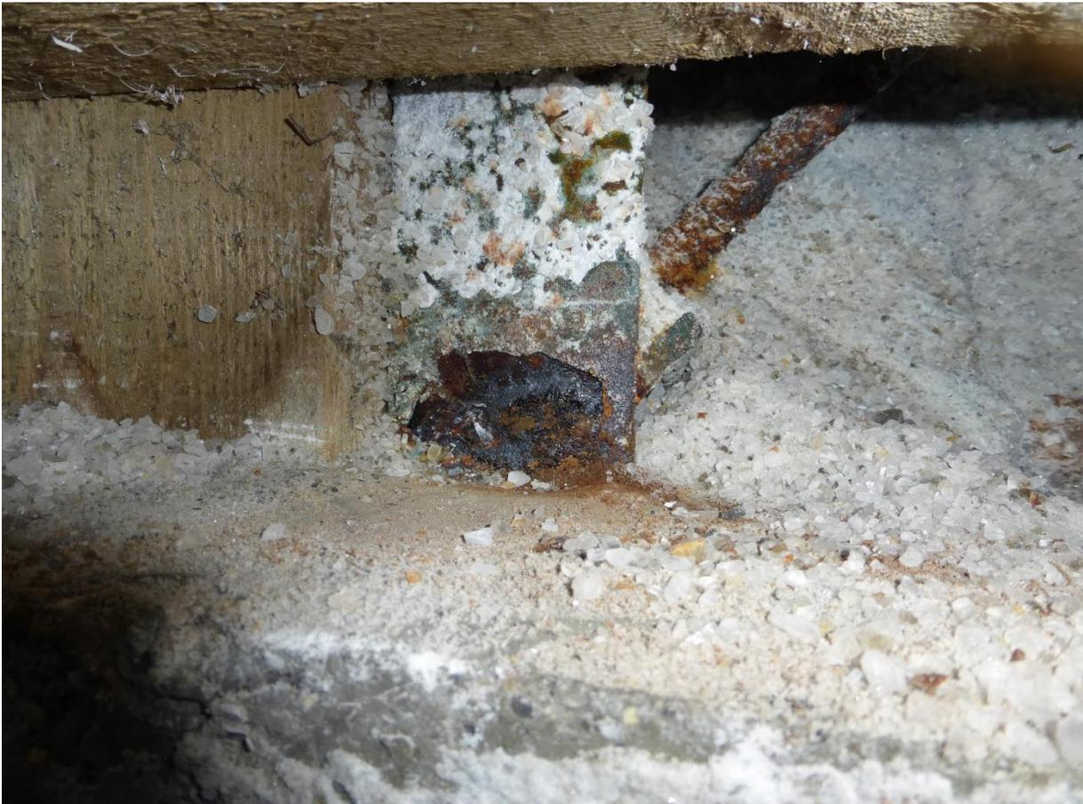
Zunehmende Schädigung an Stützeinspannungen durch Salzeintrag
