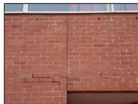
Foto Nr. 18: Frostschäden an den Fugen und Stößen über dem Unterzug
