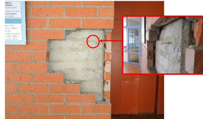
Foto 2: BS III, Erdgeschoss, Wandöffnung mit Anker
