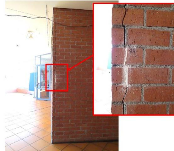
Foto 1: BS III, Erdgeschoss, Riss in der Fassade
