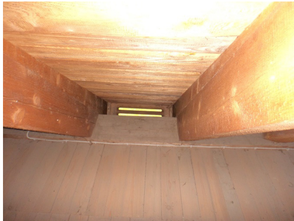
Abb. 4: Potenzielle Ein-/Ausflugsmöglichkeiten in den Dachboden (Südseite).
