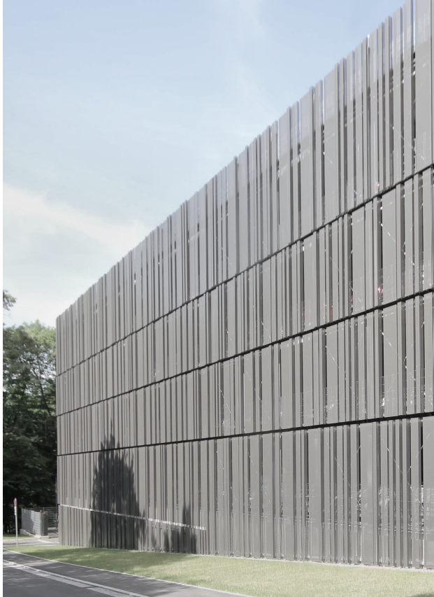
West-, Süd- und Nordfassade mit gekantetem Lochblech
