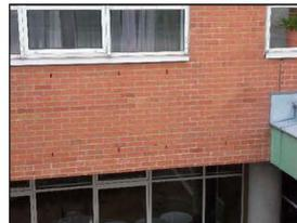
Foto Nr. 16: Frostschäden an den Fugen und Stielen über dem Unterzug
