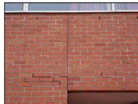
Foto Nr. 15: Frostschäden an den Fugen und Stielen über dem Unterzug
